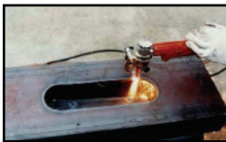
Arcos, líneas curvas
